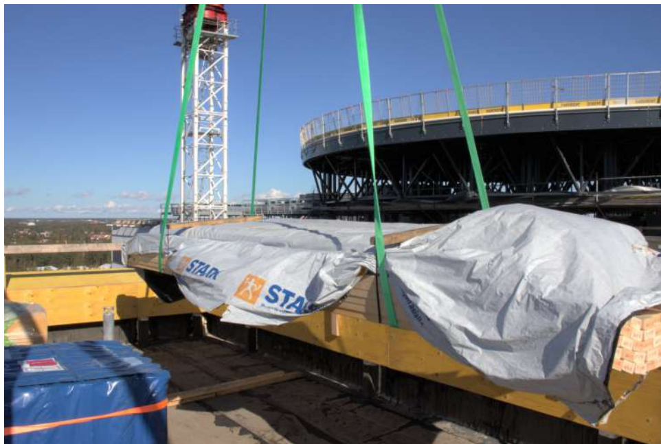
Kuva 60: U-nosto. Näin aseteltuna yhden vihreän liinan teoreettinen maksimi kapasiteetti on 4 t. Kuva: Mikko Tourunen
