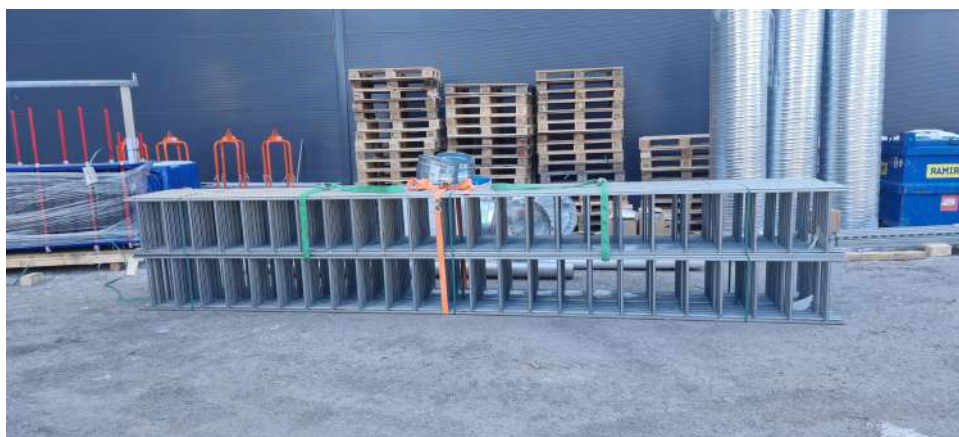
Kuva 48: Räikkäliinoja kannattaa hyödyntää nostotöissä laajemminkin. Sen kanssa kun varmistaa paketin, niin se ei leviä heti kun se on laskettu alas. Kuva: Mikko Tourunen
