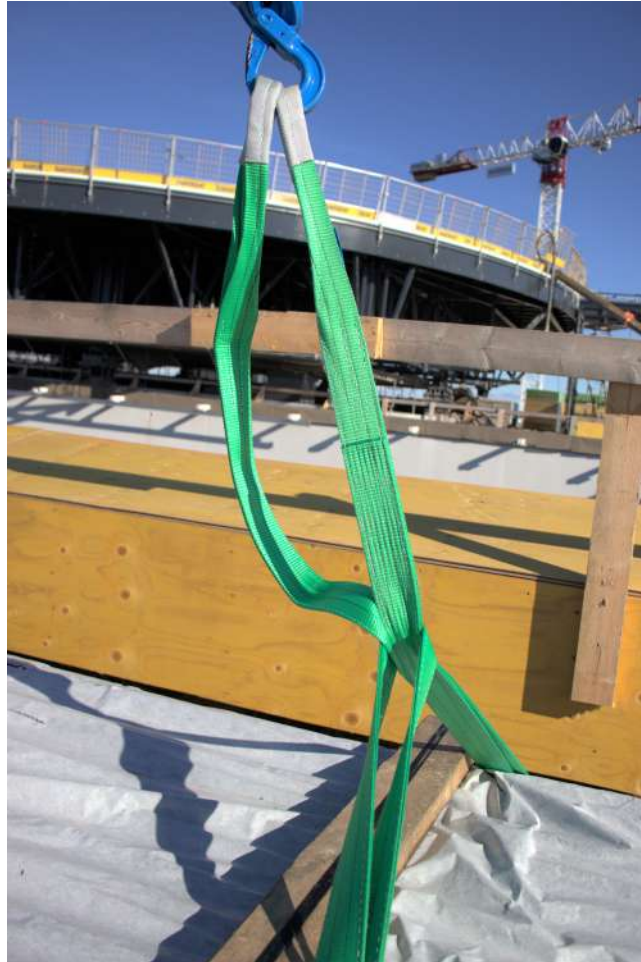
Kuva 58: Edellä esitellyn sidonnan ongelma. Jos et ole tarkkana että liinojen päät ovat saman mittaiset, veto ei jakaannu tasaisesti liinan eri haarojen kesken, jolloin kerroin ei enää ole 1.6. Kuvan tilanteessa kerroin on todellisuudessa 0.8. Ja kokemuksen myötä olen tullut siihen tulokseen, että tämäkin sidonta on parasta luokitella muotokertoimelle 0.8. Hyödytön tuo ei kuitenkaan ole, monessa tilanteessa on hyödyllistä pitää liina lyhyenä, siihen tuo toimii hyvin. Kuva: Mikko Tourunen
