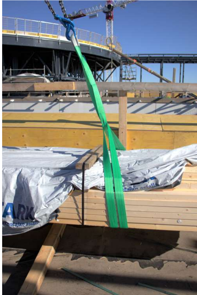
Kuva 57: Tämän sidonnan ajatus: Tässä liina on ensin taitettu kaksinkerroin, siten nostokapasiteetti on tuplattu, ja sitten kiinnitetty hirtolla, joka vähentää nostokapasiteettia. Muotokertoimeksi tulee siis 2 \times 0.8 = 1.6 . Kuva: Mikko Tourunen
