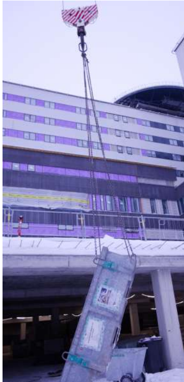
Kuva 46: Turhaa työtä. Jos laitatte koukut kiinni alhaalla oleviin tyhjennyslenkkeihin, niin ylhäällä olevat pitää irroittaa, muuten sinne alas kiinnittäminen oli turhaa työtä. Kun ketjut laitetaan näin, tyhjennyslenkeissä olevat ketjut eivät edes kiristy, eivätkä siten auta jassikkaa kallistumaan yhtään enempää. Kuva: Mikko Tourunen
