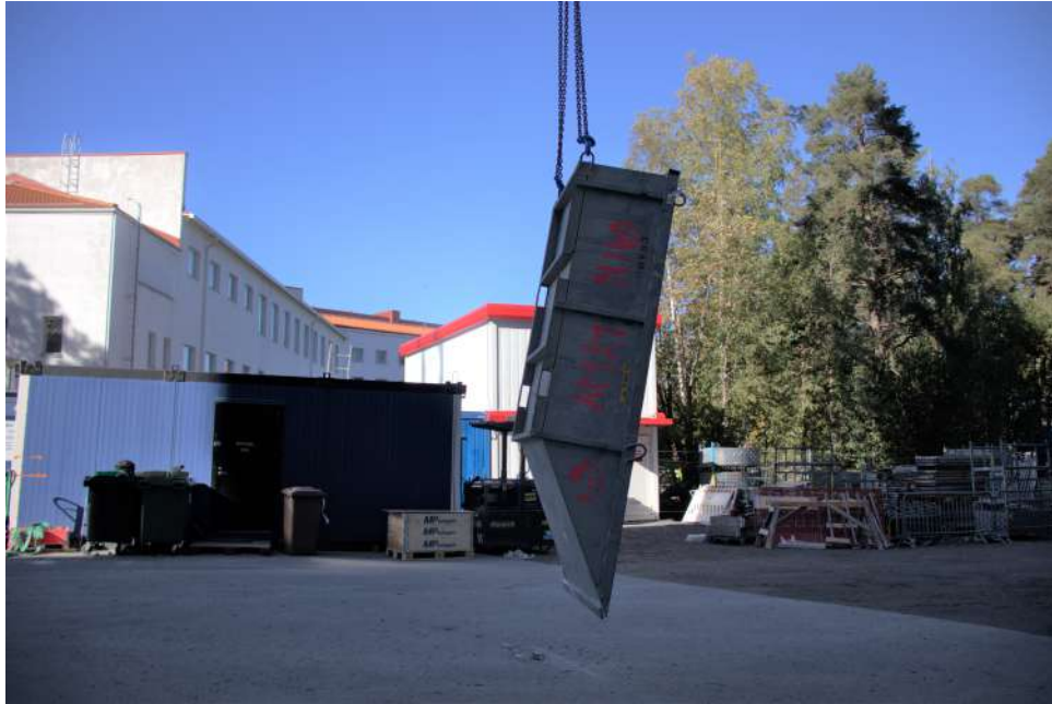
Kuva 44: Jos ei vielä tässäkään asennossa tyhjene, niin pitää kaataa kokonaan päälle, ja paukuttaa pohjaa jollain lekalla. Kuva: Mikko Tourunen
