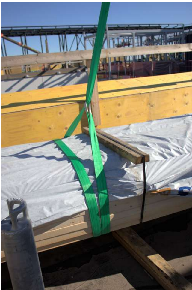
Kuva 56: Erona edelliseen liina kiertää taakan kahdesti, puristaen taakkaa 360°, muotokertoimeen se ylimääräinen kierros ei kuitenkaan vaikuta. Eli muotokerroin 0.8. Kuva: Mikko Tourunen
