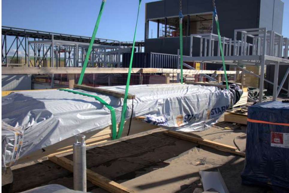
Kuva 61: U-hirtto. Muotokerroin on kaksi, ja tämä sidonta myös puristaa taakkaa joka puolelta, tehden nostosta turvallisemman. Kuva: Mikko Tourunen
