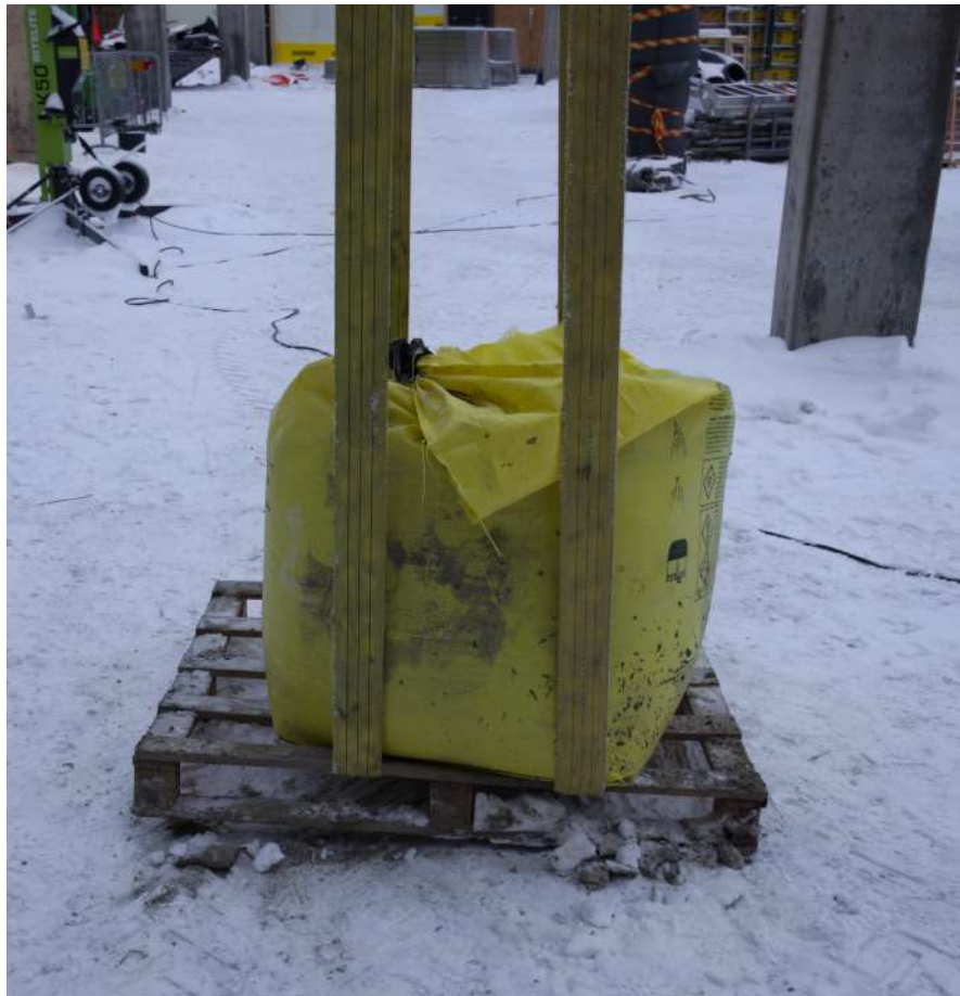
Kuva 99: Liinat kulkee suoraan säkin alla. Kuva: Mikko Tourunen
