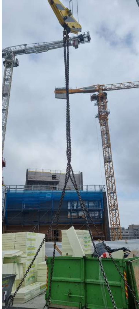
Kuva 78: Ketjut sekaisin. Kuva: Mikko Tourunen
