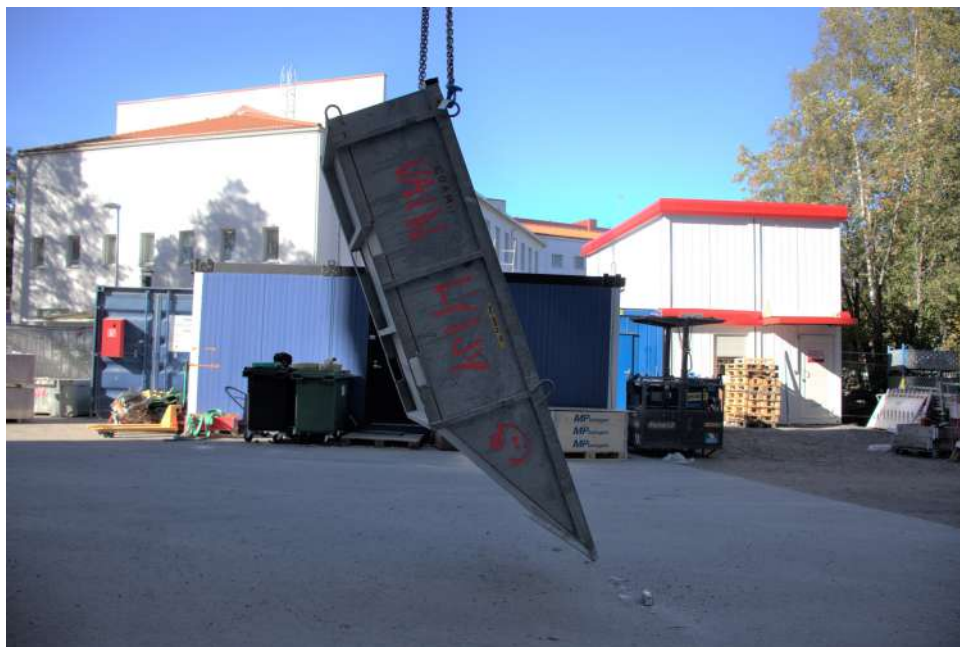
Kuva 43: Kuten näette, jassikka kallituu riittävästi kun jätetään taaemmista ylälenkeistä kiinni. Useimmiten turhaa vaivaa alkaa kiinnittämään sieltä alhaalta. Kuva: Mikko Tourunen
