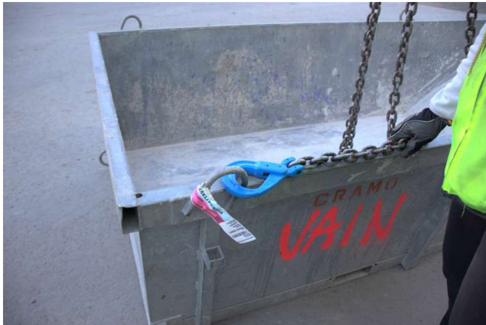
Kuva 39: Kuvassa koukku jätetty lenkin sisäpuolelle, eli puolelle josta veto tulee lenkkiin kohdistumaan, kun ketjut kiristyy. Kuva: Mikko Tourunen
