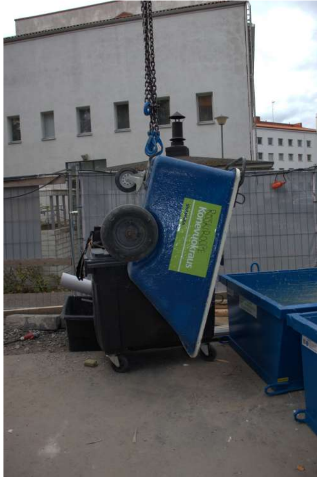
Kuva 38: Aina tyhjennettäessä, täältä takaa, alhaalta, tyhjennyslenkistä kiinni, niin kallistuu riittävästi. Kuva: Mikko Tourunen
