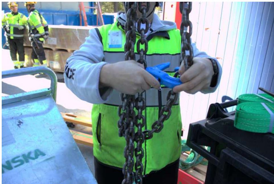
Kuva 34: Pyöräytät muiden ketjujen ympäri, ja hirtät itseensä kiinni. Kuva: Mikko Tourunen
