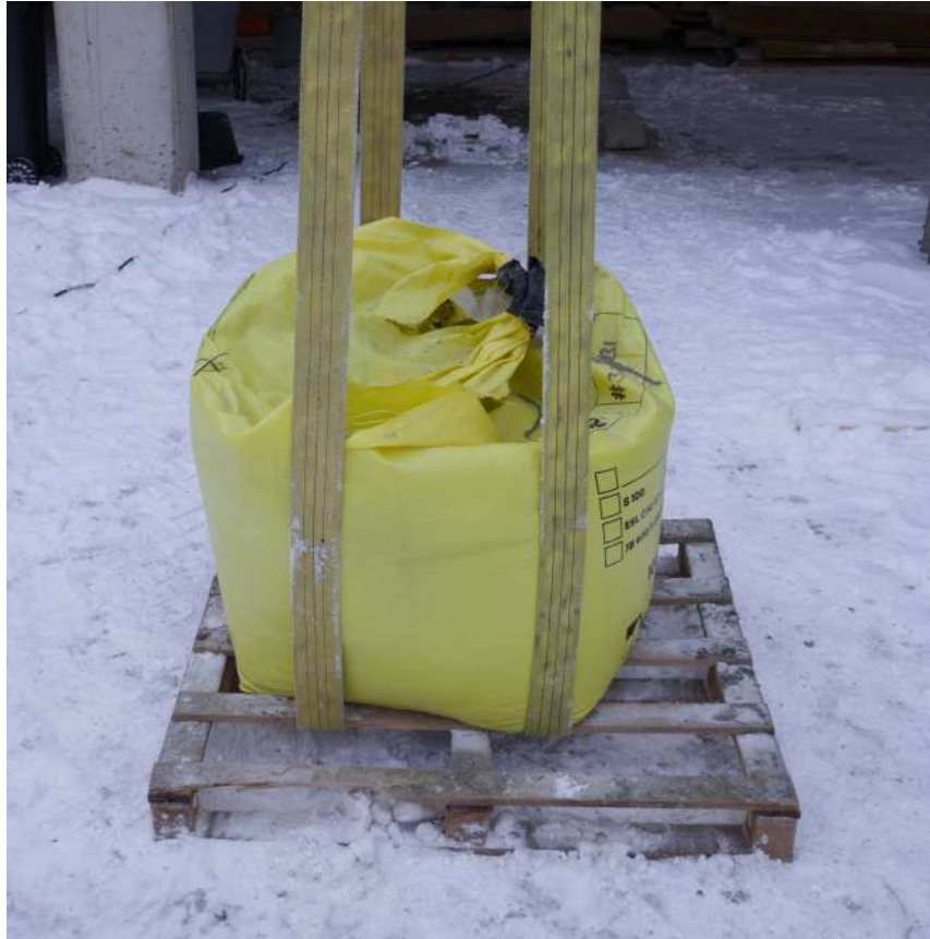
Kuva 100: Liinat pujoitettu raosta, joka on lähinnä säkkiä. Kuva: Mikko Tourunen
