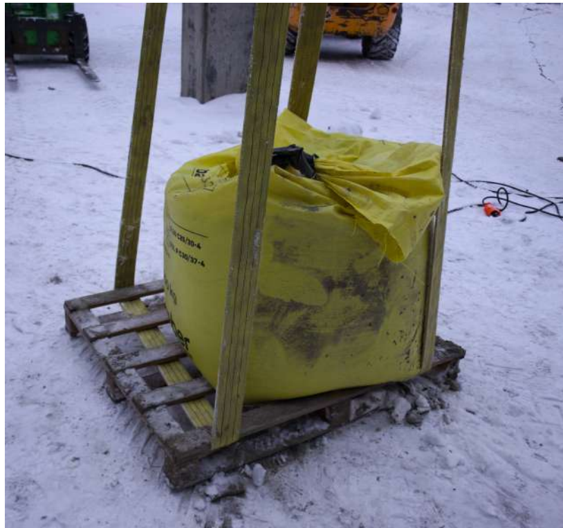
Kuva 98: Jos tarkoituksenne on tappaa joku alamiehistä, tämä sidonta antaa hyvät onnistumisen mahdollisuudet. Kuva: Mikko Tourunen
