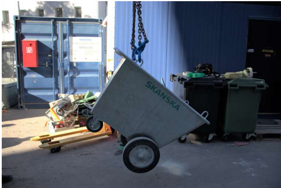
Kuva 36: Kuten näet, ei kallistu läheskään riittävästi. Kuva: Mikko Tourunen
