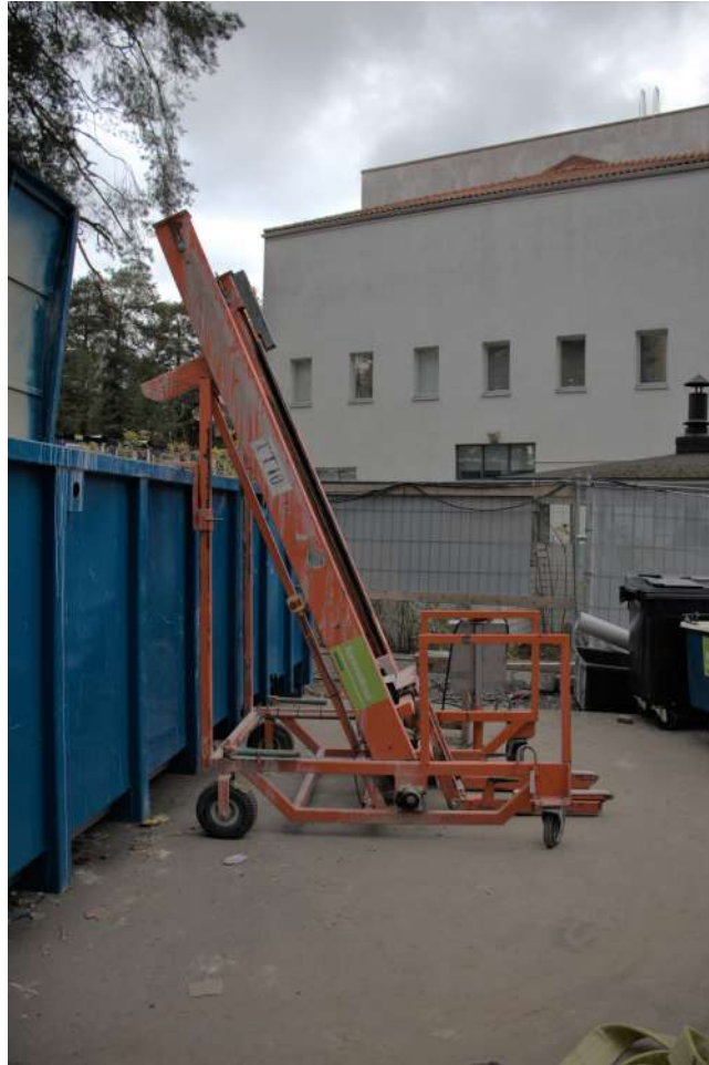
Kuva 30: Kippauslaite, jolla kerroskärret saa tyhjennettyä suoraan lavalle, ilman nosturia, ja ilman että sinun täytyy mennä räpimään sinne lavalle. Kuva: Mikko Tourunen
