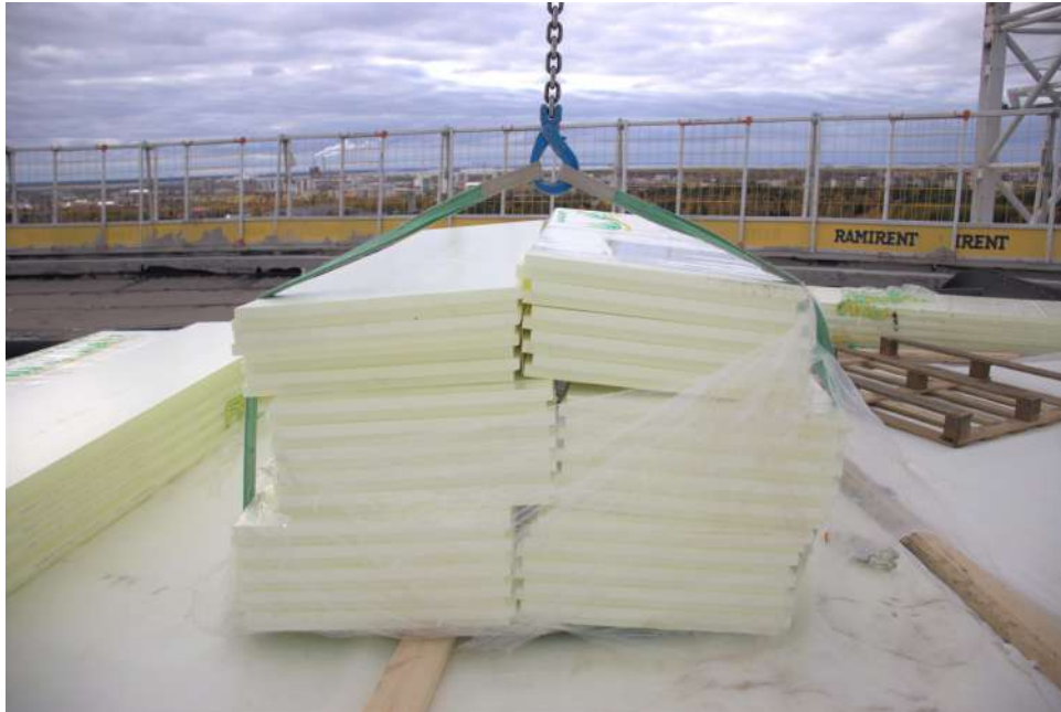
Kuva 63: Liian suuri haarakulma liinoissa. Vedon kuuluisi kohdistua koukkujen pohjaan, ei niiden seinämille. Ja erityisen suuren riskin tällainen juosten kustu sidonta aiheuttaa, kun käytössä on valkoiset liinaat, jotka ovat todella ohuita, ja siihen päälle vielä väljäksi mennyt koukku, eli koukun leukojen välissä on rako, josta se valkoinen liina mahtuu livahtamaan läpi. Tässä olisi pitänyt käyttää jatkohirttoa. Kuva: Mikko Tourunen
