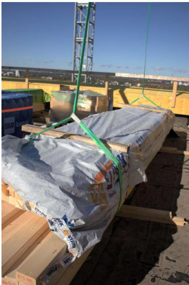
Kuva 55: Niin sanottu perushirtto, se tavallisin tapa kiinnittää taakka hirttämällä. Muotokerroin 0.8. Kuva: Mikko Tourunen
