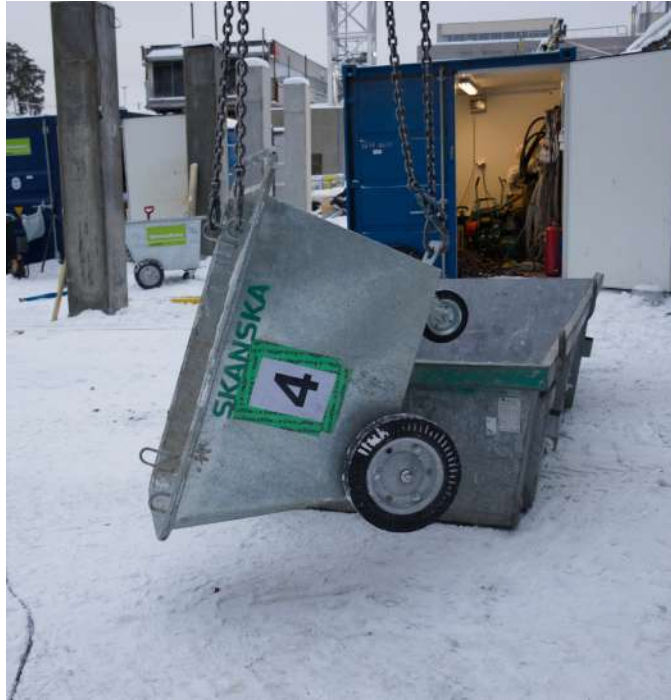
Kuva 37: Aika tavallista, että jätetään nuo taaemmat ketjut kiinni, ja yksi tyhjennyslenkkiin kiinni. Ajatellaan että tämä nopeuttaa hommaa kun vähemmän pelaamista ketjujen kanssa. Mutta ei kallistu riittävästi, jotta tyhjenisi kunnolla. Kuva: Mikko Tourunen
