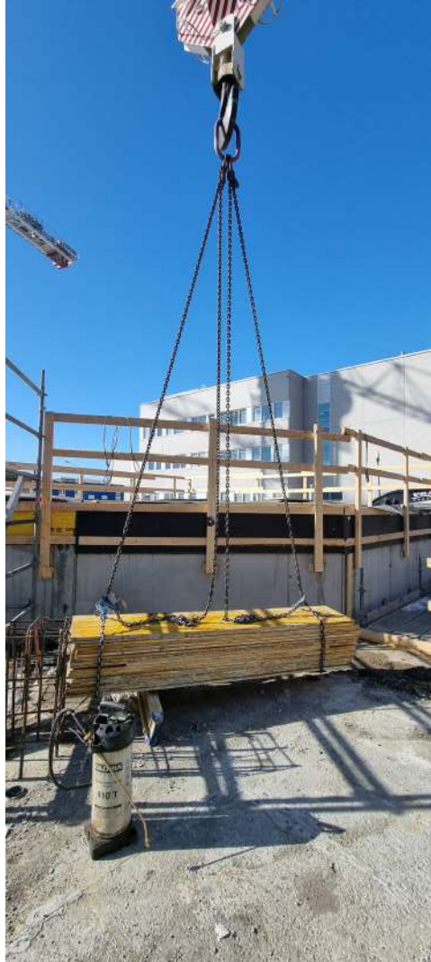
Kuva 72: Taakat voi tarvittaessa hirttää suoraan ketjuilla, jos ei ole liinoja lähimain. Kuva: Mikko Tourunen
