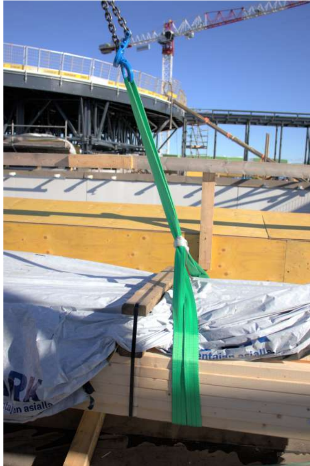
Kuva 59: Vaihtoehtoinen M 1.6 sidonta. Muistan nähneeni jossain nosto-oppaassa tätä sidontatyyliä sanottaneen varmaksi tavaksi saada siihen muotokerroin 1.6. Mutta kokemus on myöhemmin osoittanut ettei tähänkään voi luottaa, joten suositukseni on, kun halutaan pelata varman päälle, että tällekin sidonnalle annetaan muotokerroin 0.8. Kuva: Mikko Tourunen
