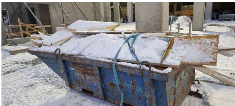
Kuva 47: Ylitäyteen lastatut jassikat kannattaa varmistaa kuormaliinalla. Ja jos on kova tuuli, ja jassikassa jotain kevyempää tavaraa, kuten jotain eristelevyä, niin kannattaa varmistaa kuormaliinalla, vaikka ei olisikaan yli reunojen täytetty. Kuva: Mikko Tourunen
